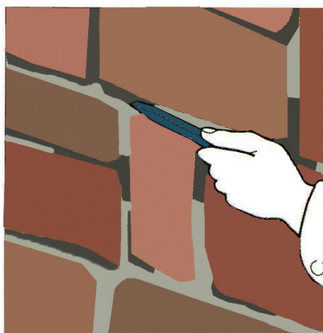
Figura 7 Curățarea rosturilor zidăriei și repararea rosturilor cu mortar
