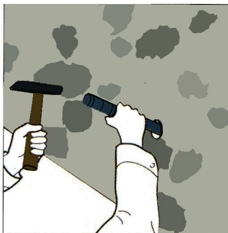
Figura 4. Introducerea tijelor perforate în orificiile prin care se va efectua injectarea
